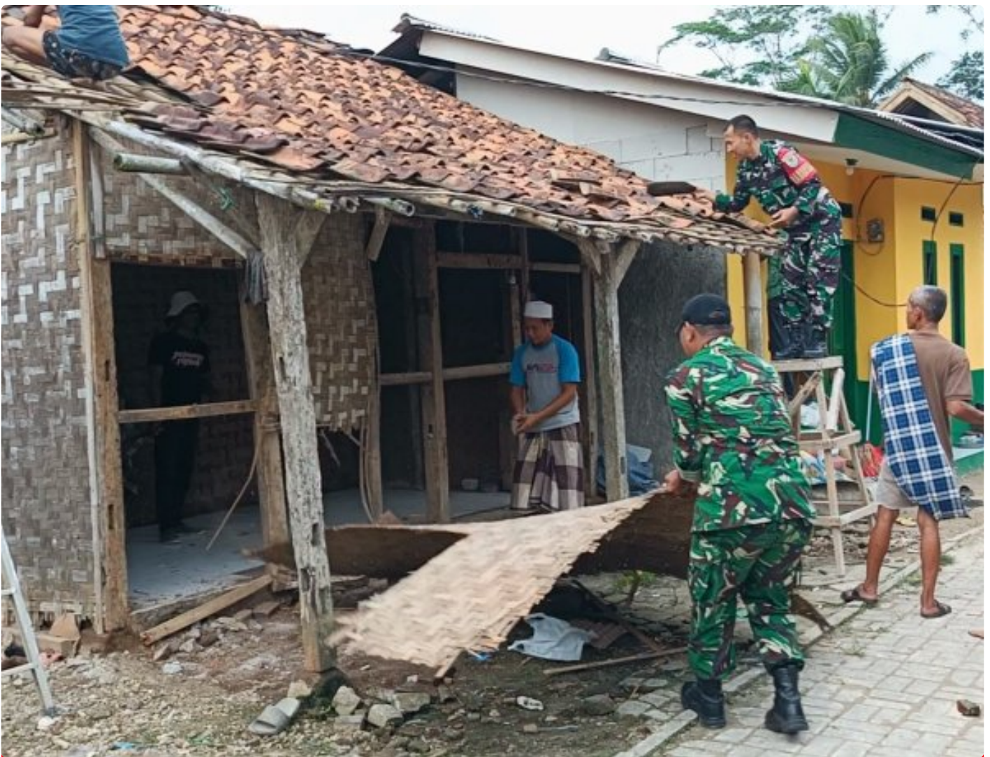
Pembongkaran Rumah Bapak Narmin
